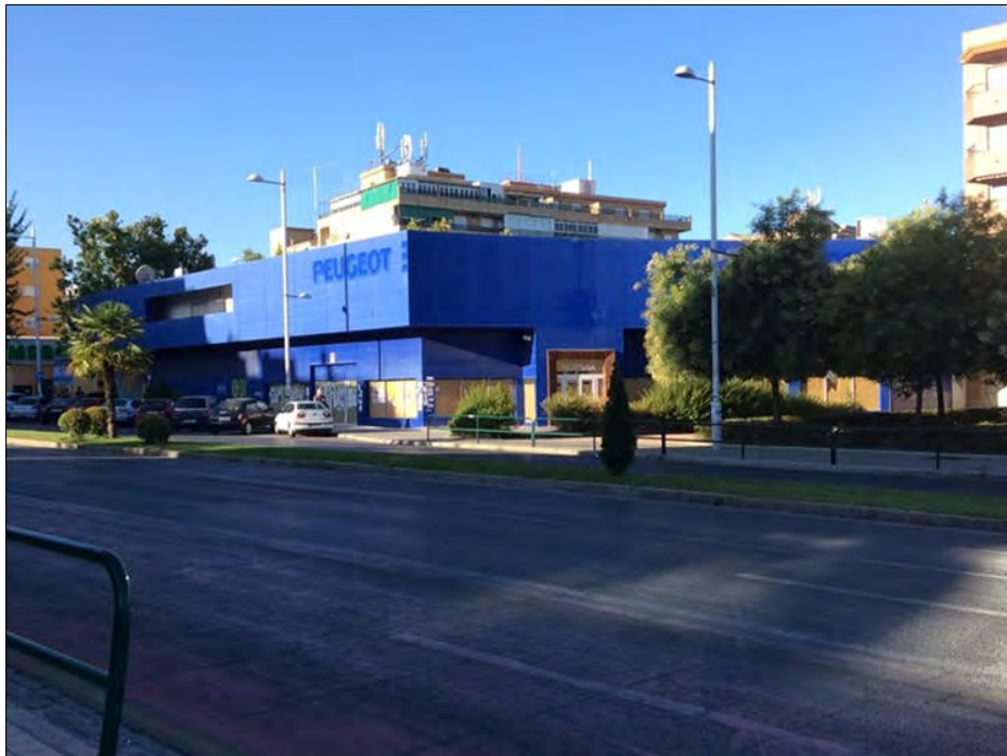
Imagen de la anterior fachada de la nave industrial; concesionario de vehículos y taller (Fuente: D.G.del Catastro)
