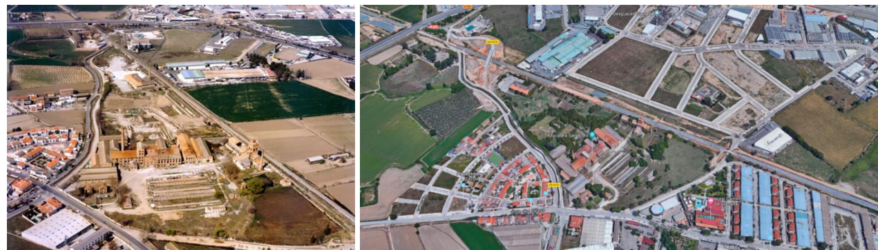
Vista aérea / Vista aérea Google, estado actual.
