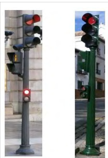
Figura 4: Columnas de fundición
