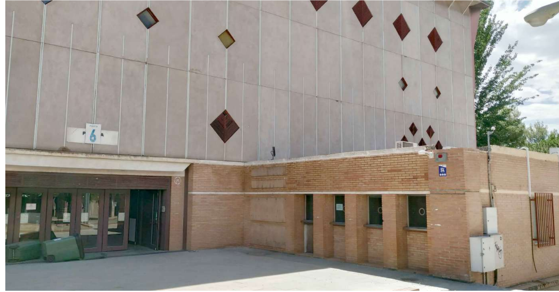
Fotografía 3, zona de taquillas en la fachada oeste
