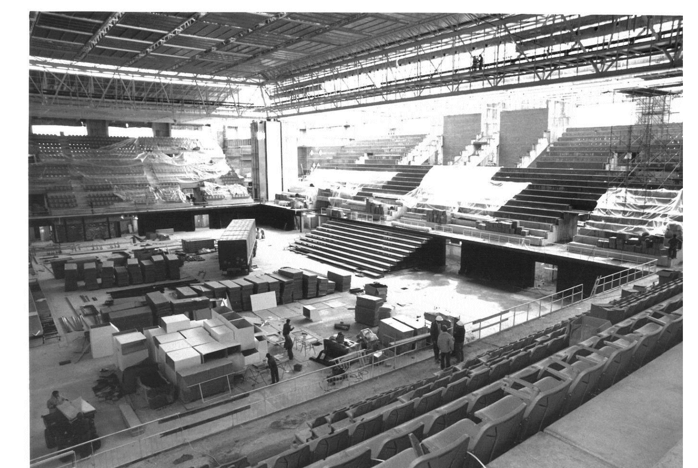
Fotografía del montaje del graderio en el interior del palacio
