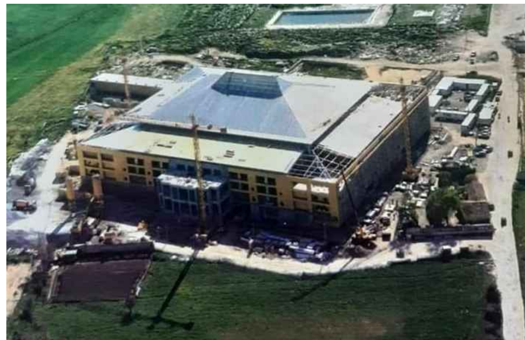
Fotografía de la ejecución del palacio de deportes desde el aire
