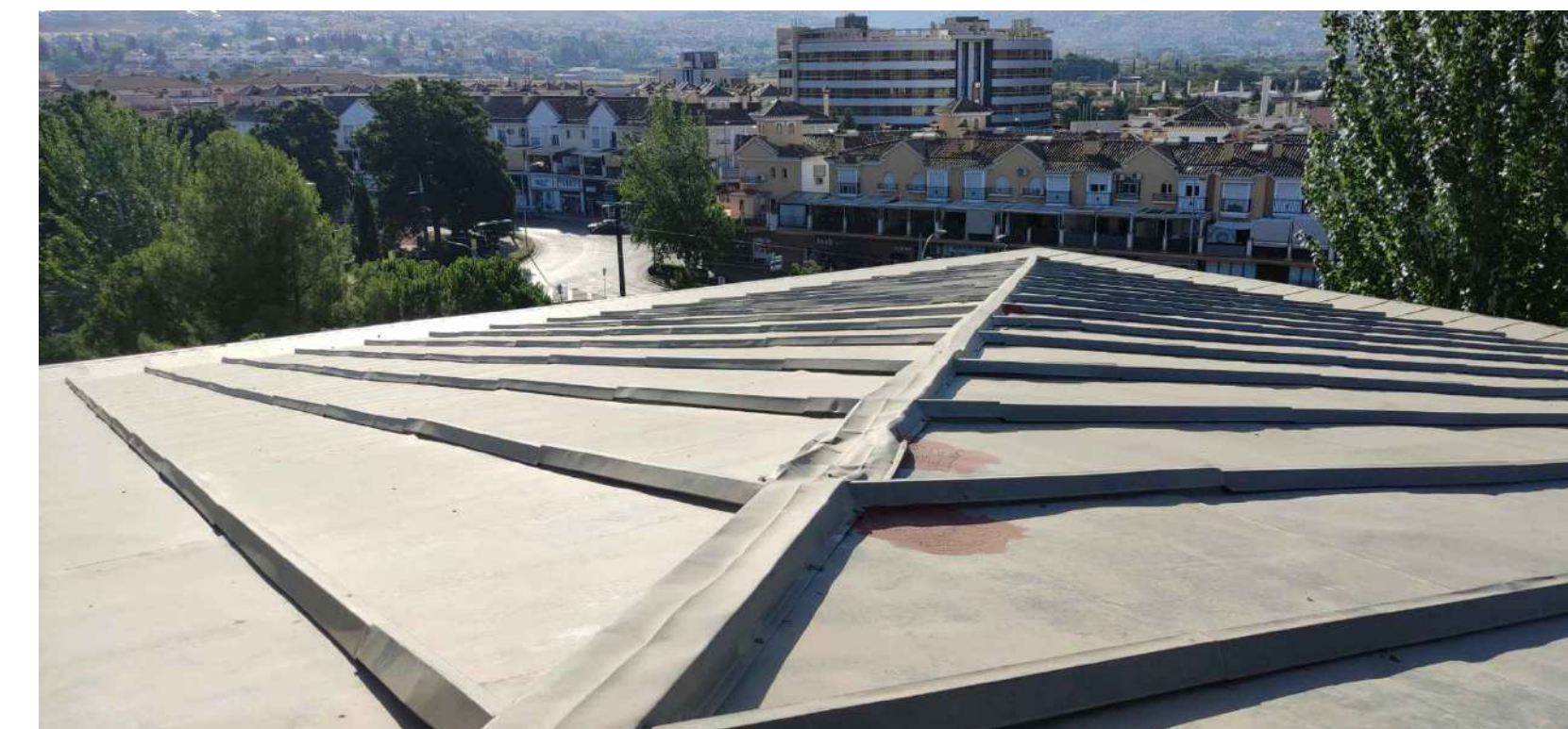
Fotografía 11, Vista encuentro faldón sureste y suroeste
