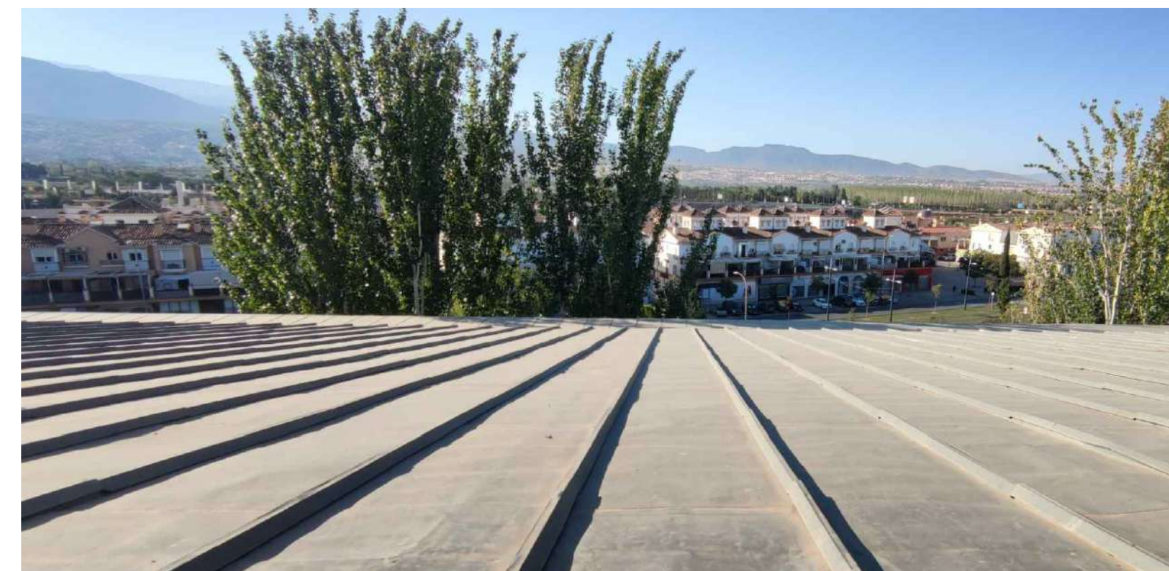
Fotografía 10, Vista faldón suroeste
