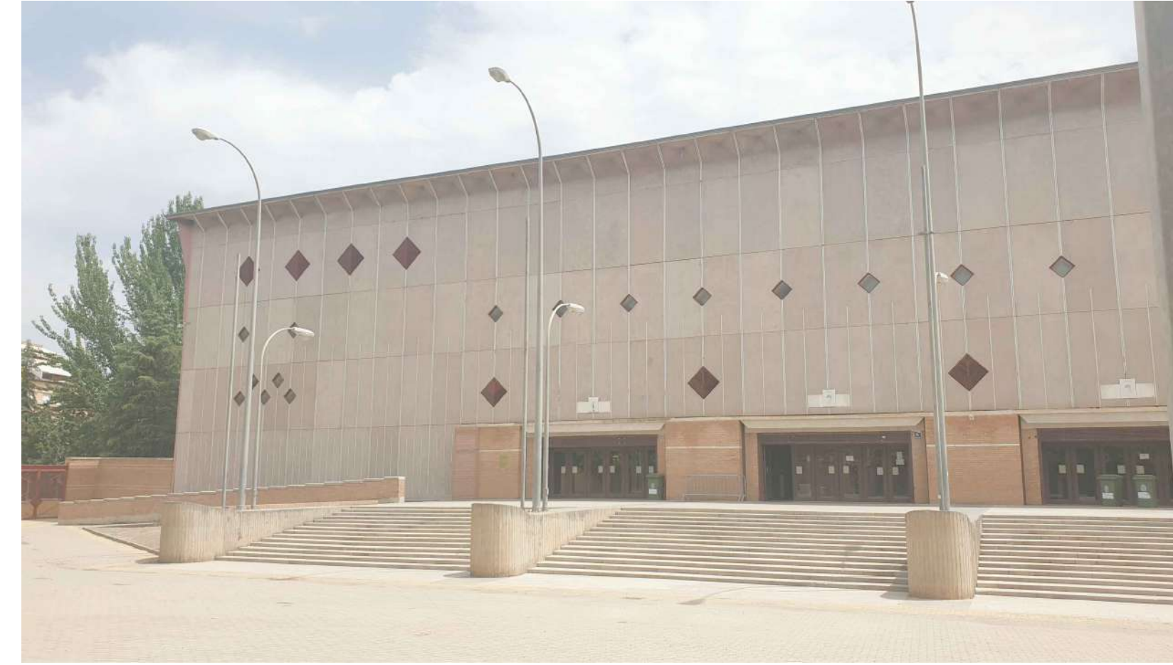
Fotografía 4, Escalinata y acceso al público, fachada oeste
