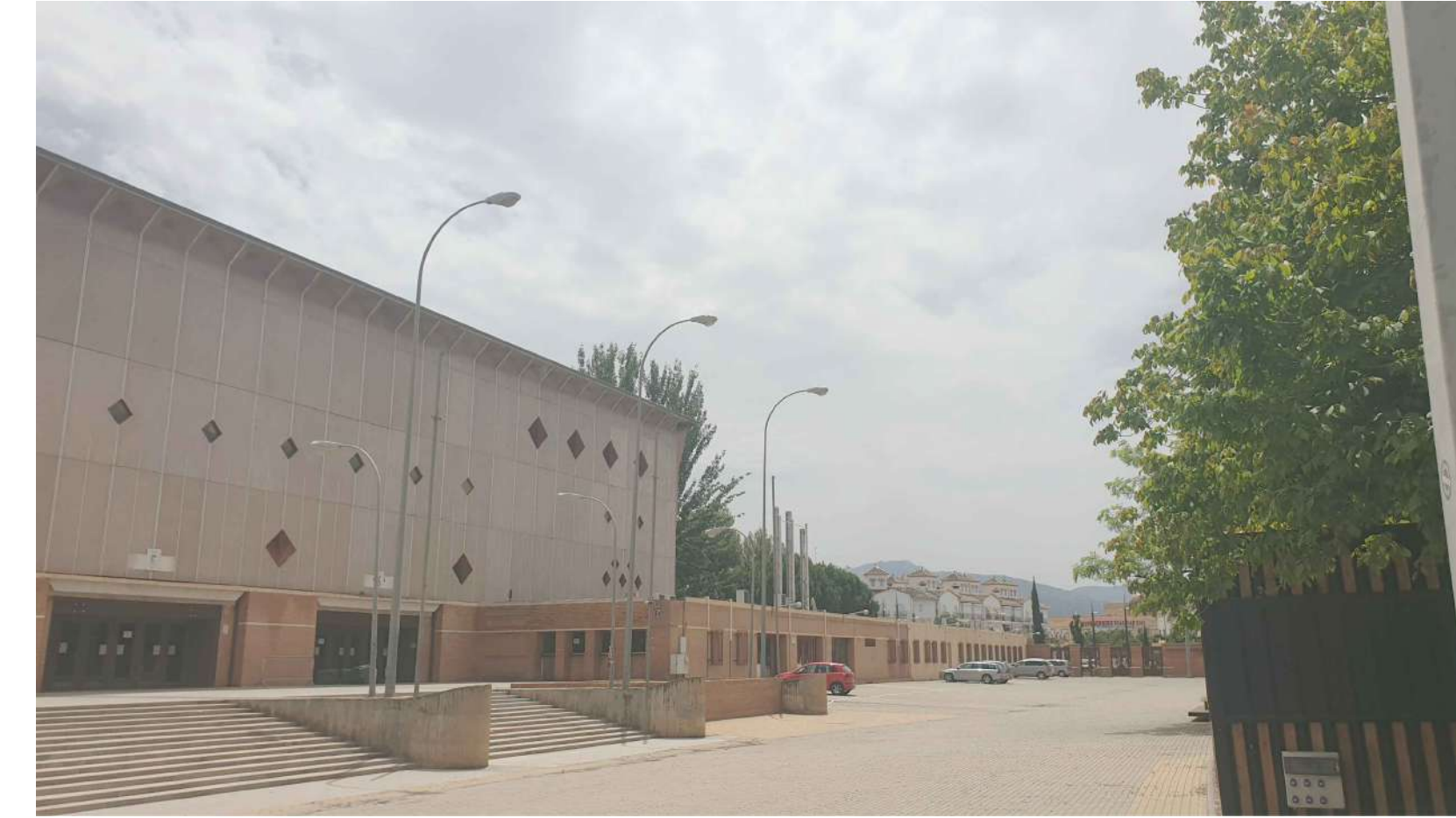
Fotografía 5, Escalinata y acceso al público con zona de taquillas, fachada oeste
