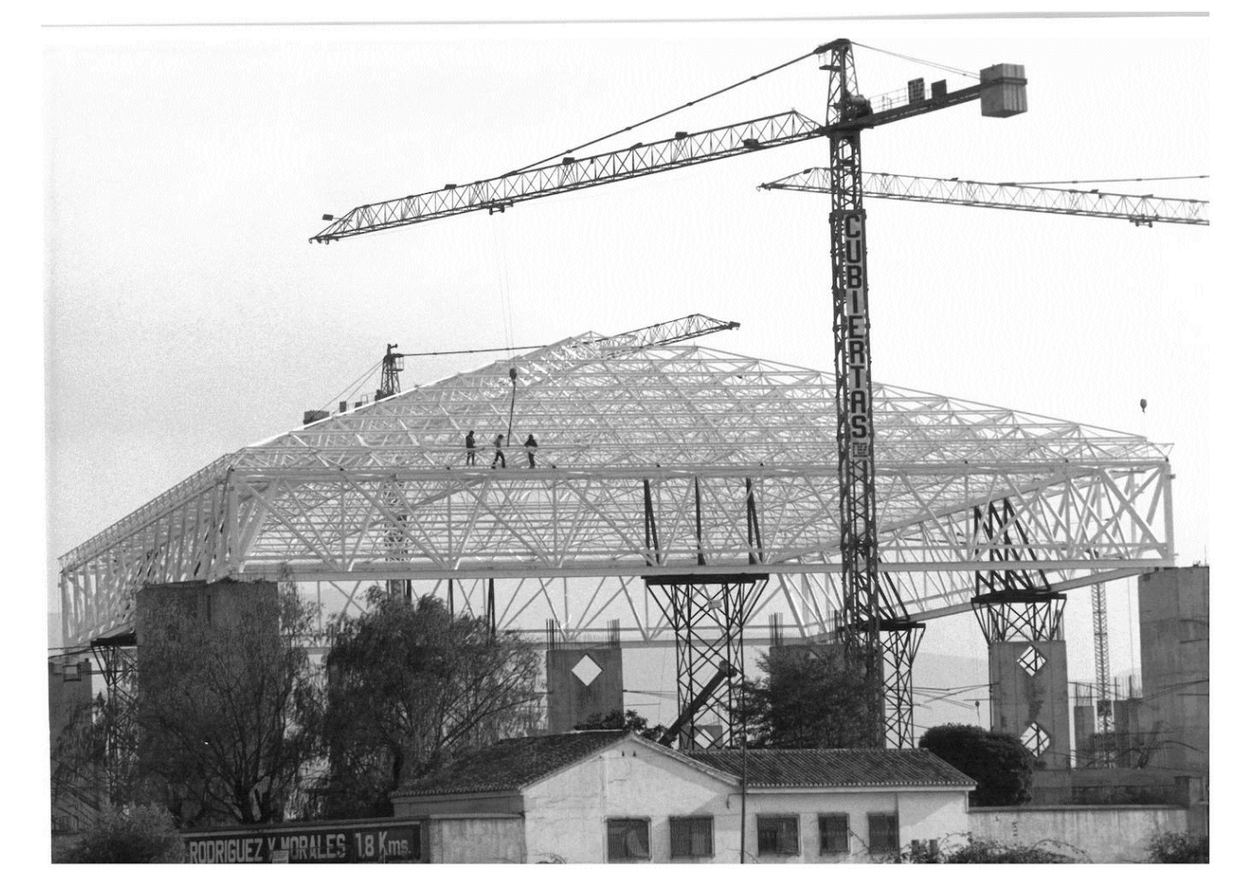
Fotografía del montaje de la estructura de la cubierta del palacio
