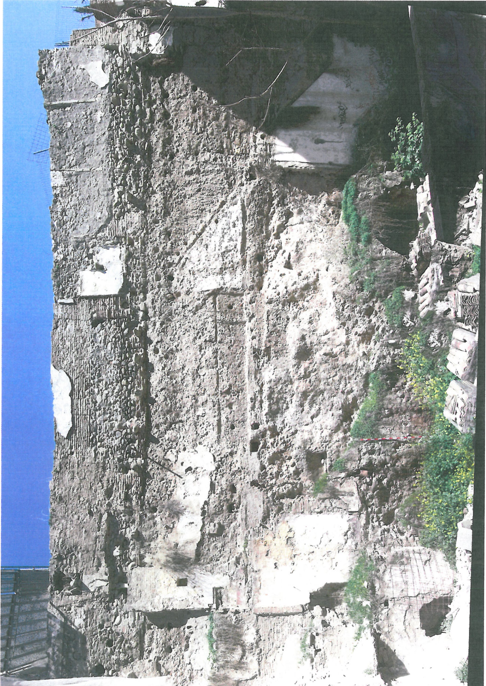
Fotografía 2: Estado actual de la muralla y de la tapia de coronación al exterior. Los diversos añadidos en el muro responden a las edificaciones del siglo XIX-XX demolidas con anterioridad y que se entestaron sobre la muralla al igual que el garaje del palacete lo hizo (veanse el Plano de 2002 JUNIO, en fotografía 4).
